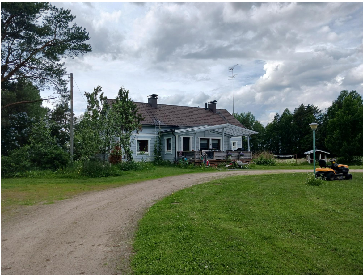
Kuva 3. Jokiranta-tilan päärakennus vuonna 2024.
